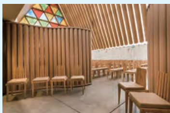
紙管は、防水が施された直径600mmのものを使用。
