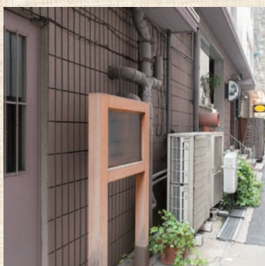
大阪支店から徒歩1分の太閤下水 いまでも約40kmが現役の地下水路として息づく
