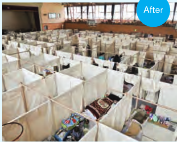
坂氏の活動は、東日本大震災の災害支援にも及んでいます。コンテナを利用した仮設住宅のほか、避難所の生活でプライバシーを確保できるよう設計された紙管を用いたパーティションは、じつに50カ所以上の避難所に設置されました。(写真は岩手県大槌高校の体育館)
