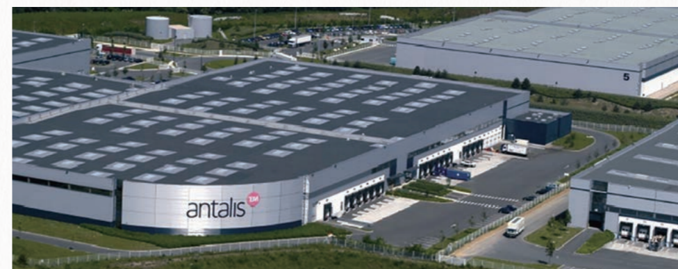
アンタリス倉庫セナート
