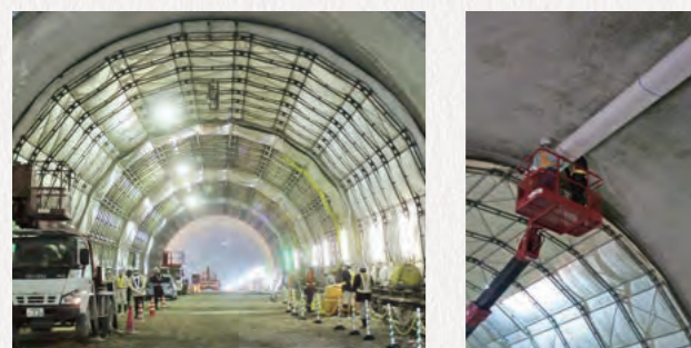
キュアマイスターの施工現場
