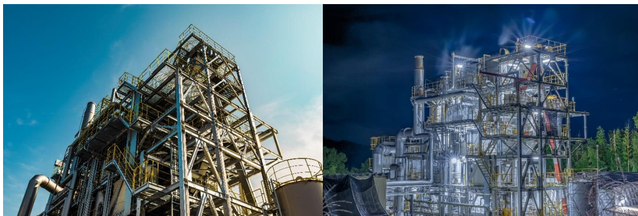
パワーエイド三重シン・バイオマス®松阪発電所
