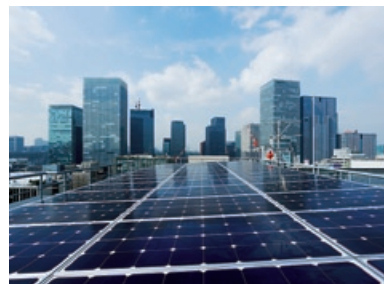
屋上に太陽光パネルを設置
